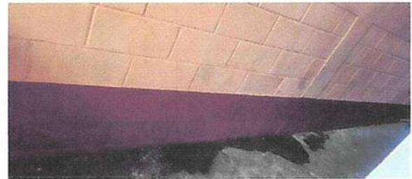
Foto 6: Filtración de agua externa en muro perimetral
